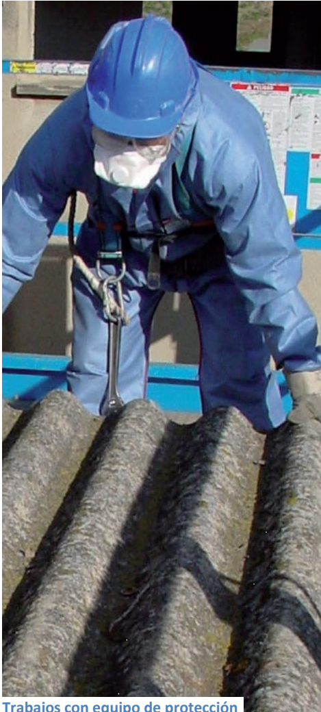
Trabajos con equipo de protección
