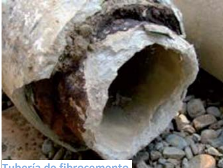
Tubería de fibrocemento
